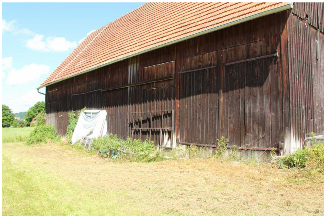
Foto 4: Südseite der Feldscheune mit Ruderalflur
